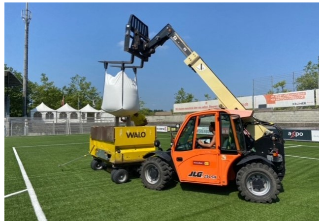
Der Rasen wird für die Verfüllung mit dem Korkgranulat vorbereitet.
