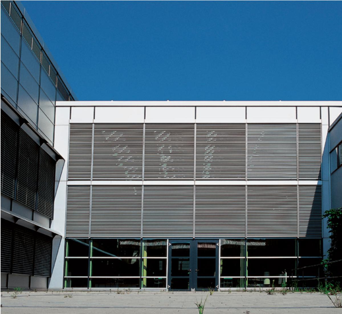
sammenhang von Sonnenschutz und Beleuchtung zu beachten: Der Sonnenschutz soll so viel Tageslicht durchlassen oder so eingestellt werden können, dass die Beleuchtung nicht eingeschaltet werden muss und deren Abwärme sich nicht negativ auswirkt bzw. weggekühlt werden muss. Generell gilt aber: Der Solarertrag ist in der Regel gewichtiger als die Abwärme einer effizienten Beleuchtung.
